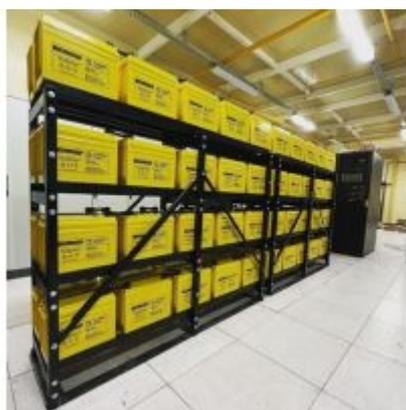
Металлические стеллажи сокращают место и удешевляют аккумуляторное решение. В Yellow Battery предусмотрели, чтобы произведенные стеллажи соответствовали требованиям для размещения свинцово-кислотных аккумуляторов. Открытая конструкция облегчает доступ к аккумуляторам для обслуживания, а сборно-разборная конструкция упрощает транспортировку и монтаж.
